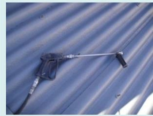
高圧水洗：下地調整面が湿潤状態になるためアスベスト繊維の空気中の飛散を一定程度抑制可能な方法として設定、洗浄廃水が排出される
