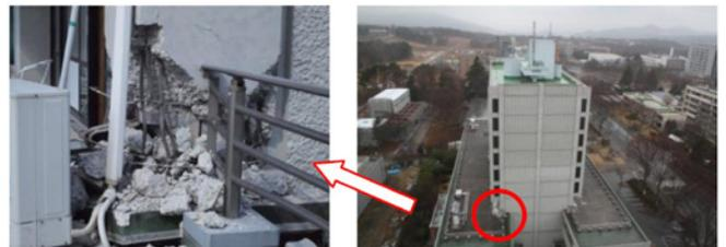
妻壁両端隅柱の柱脚部の被害状況<sup>18)</sup>
