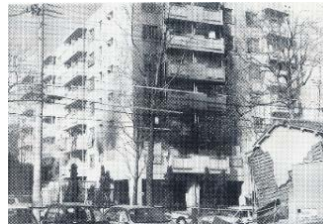
写真1 7階建共同住宅での火災 日本建築学会:阪神・淡路大震災調査報告(1998)
