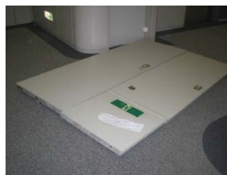
写真4 防火扉の損傷例 日本火災学会:東日本大震災火災等調査報告書(2011)
