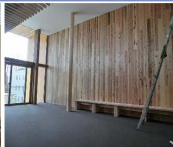
写真2 6mの通し壁を用いた開放的な空間
