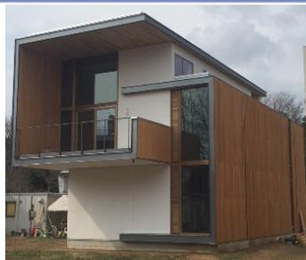
写真1 CLT実験棟(片持ちのベランダ)
