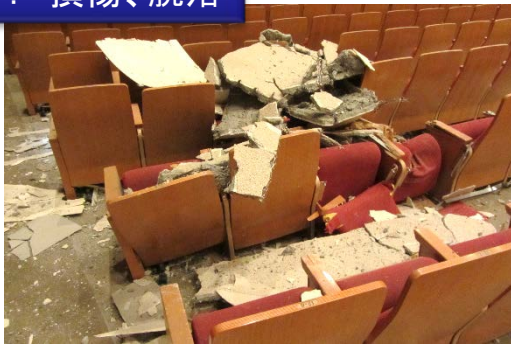
鉄網にモルタルを塗った重たい天井の脱落
