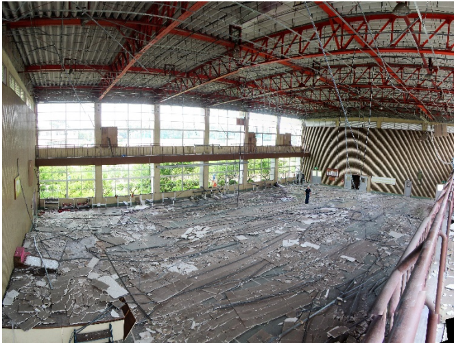
在来工法天井の全面的脱落
