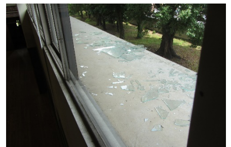
硬化性パテでとめたガラスの破損
