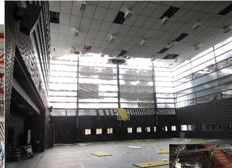
システム天井の被害
