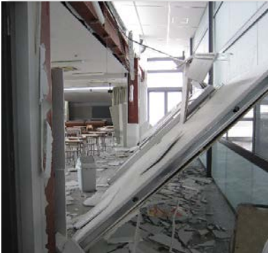
間仕切り壁の転倒
