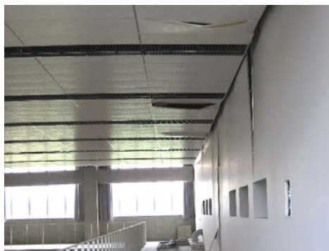
天井と壁の衝突による損傷
