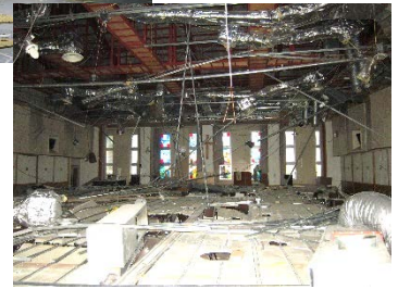
在来工法天井の全面的脱落
