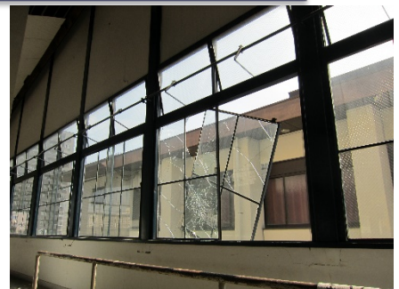
ガラスの損傷及び窓障子の外れ
