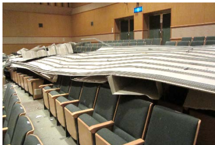
在来工法天井の脱落
