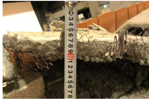
鉄網にモルタルを塗った重たい天井の脱落
