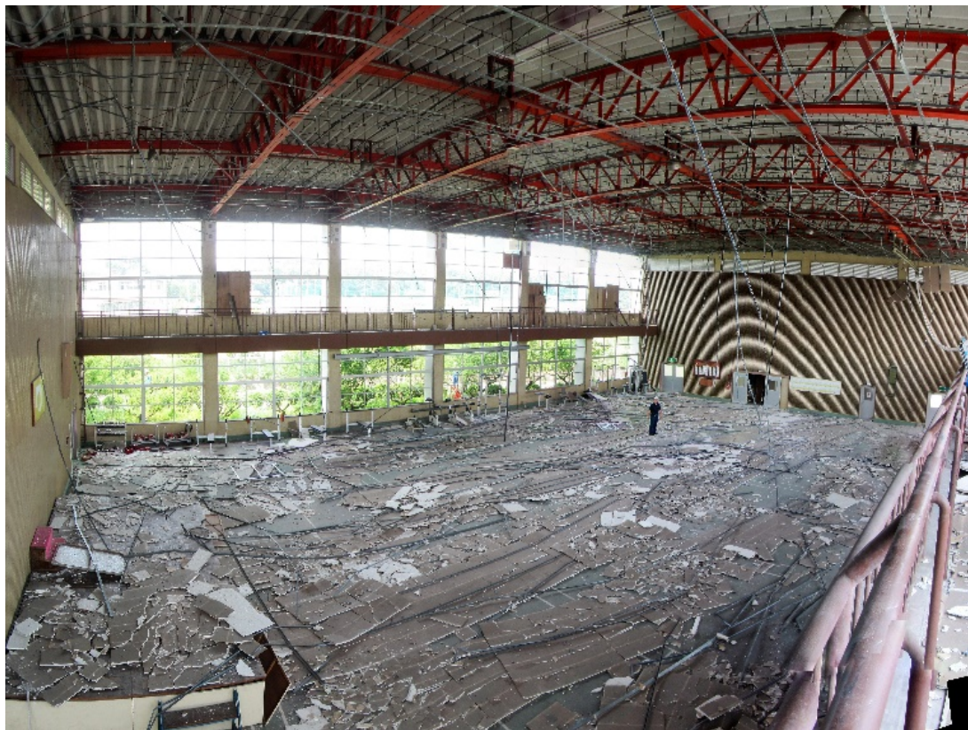
在来工法天井の全面的脱落
