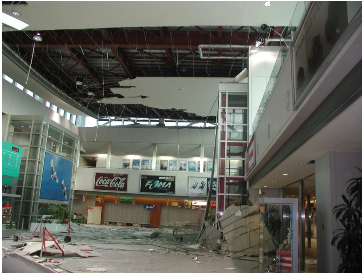
空港ターミナルビル天井の被害(2003年十勝沖地震)
