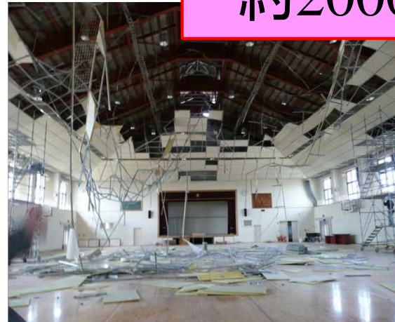
体育館における天井の脱落
