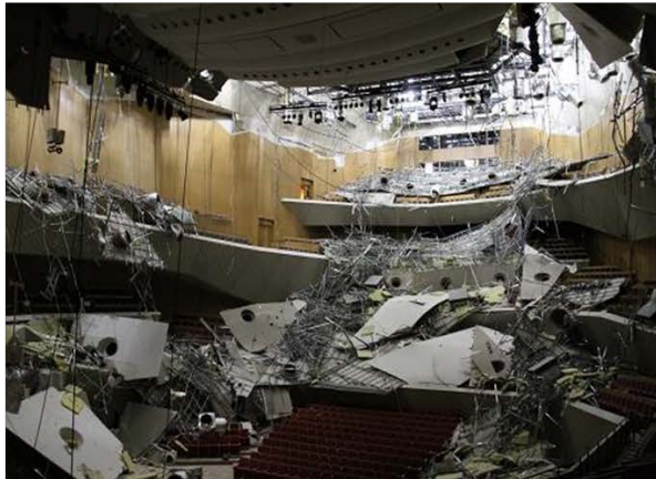
音楽ホールにおける天井の脱落
