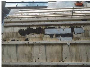
写真6 棟部で屋根下地（巻木端）が燃え抜けた例
