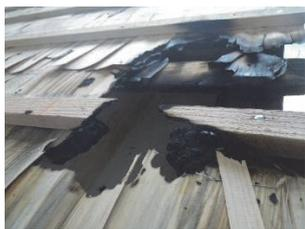
写真7 瓦棧付近で燃え抜けた例
