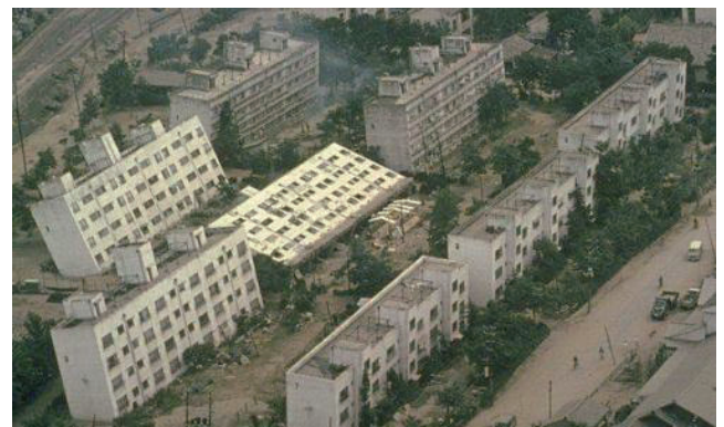
写真2 1964年新潟地震・川岸町アパートの被害状況 5)
