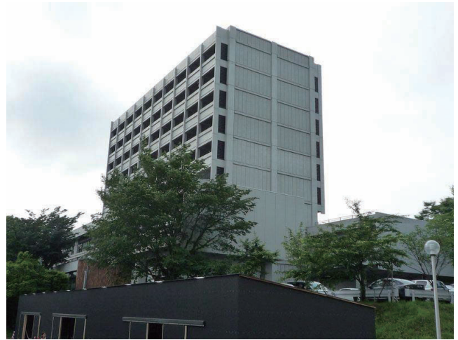
写真5 被災前の東北大学人間環境系研究棟
