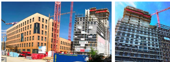
建設中の24階建事務所・ホテル等複合建築物（木・RC混構造）（ウィーン・オーストリア）
