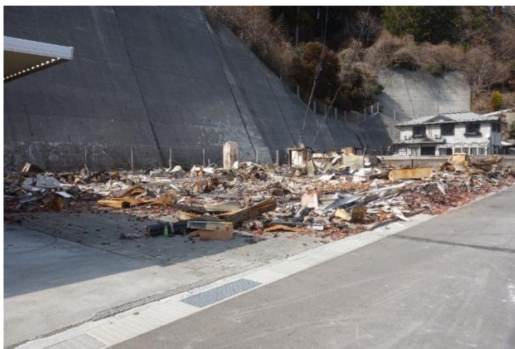
火災後の様子(港地区)
