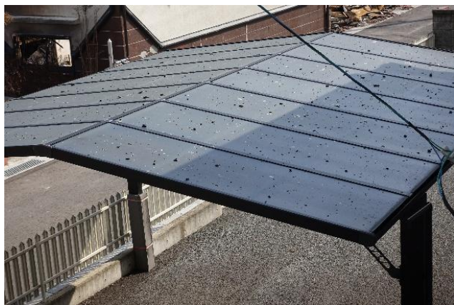
カーポート上の燃えさし (港地区)
