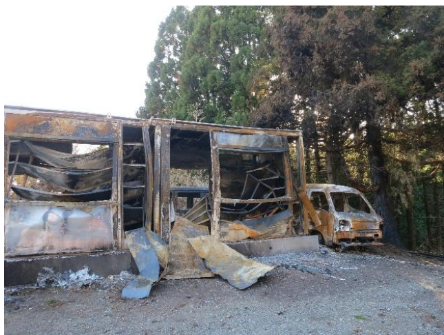
焼損した倉庫と見られる構造物と車両
