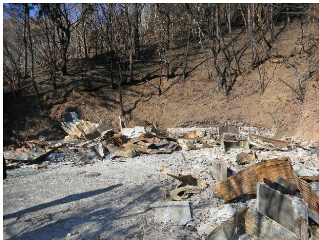
山林に近接した位置にある建物の焼損状況
