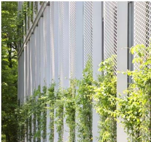
エコスキン 01: ライトシェルフ、自然風力換気窓、日射遮蔽用袖壁を組み込み「森からの風」と「自然光」を導き、窓際閲覧空間を創出する外装システム。
