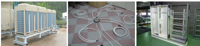
【空調】室外機ユニット 労務縮減と同時に廃棄物削減を通じて施工段階でのCO 2 を低減
