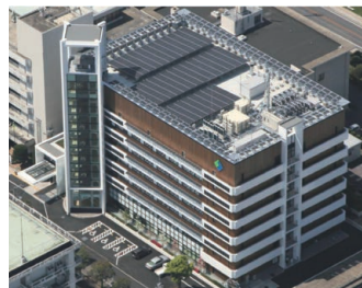
防災拠点用の電源としても使用する太陽光発電
