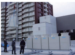
ヒートポンプ室外機搬入
