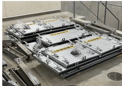
③ 歩行者車両動線に設置 予定の手動防潮版
