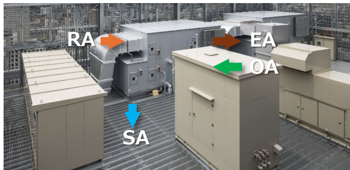
外調機による潜熱処理
