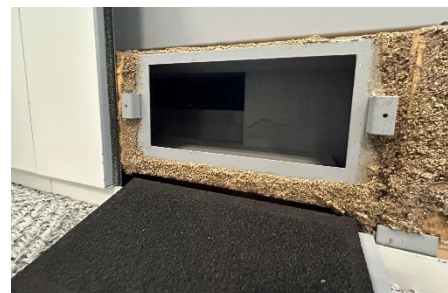
外気導入機構(内部・室内側)
