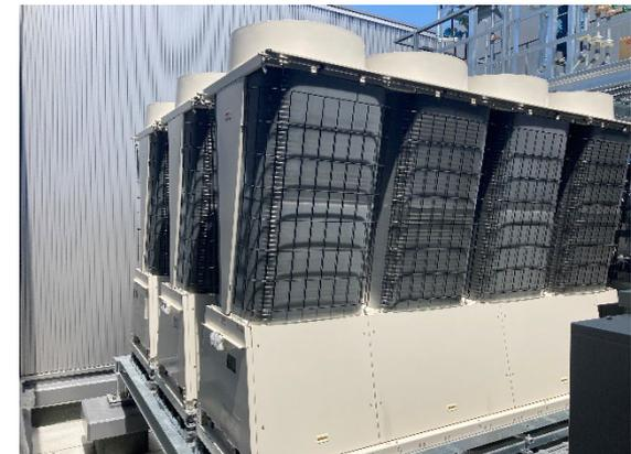
散水式高効率空冷ヒートポンプモジュールチラー
