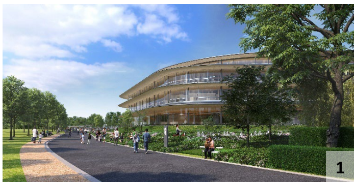
はらっぱの記憶に呼応する、公園の風景と環境をつなぐ大屋根の建築
