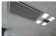
空調立上り時に稼働する ペリメータのチルドビーム
