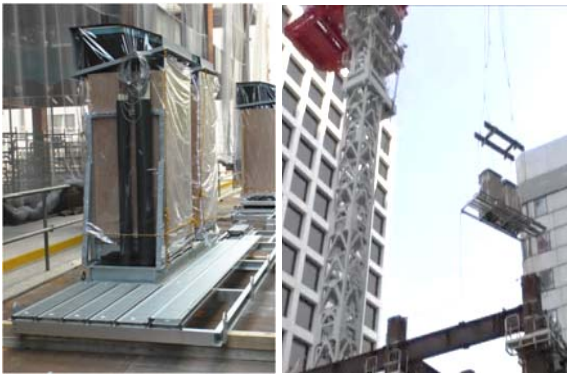
室外機ユニット
