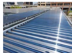
太陽熱集熱パネル
