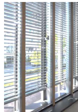
高断熱ガラスへの取替
